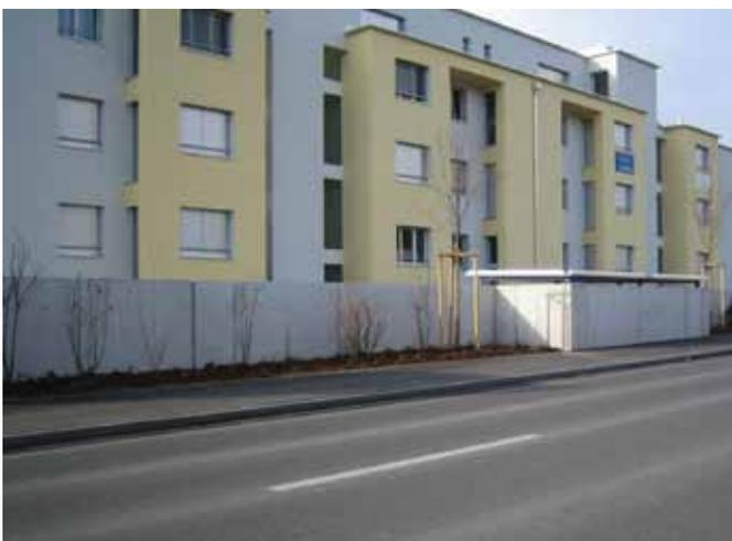
*Schalungsglatte, auf die Überbauung abgestimmte Betonmauer.*
