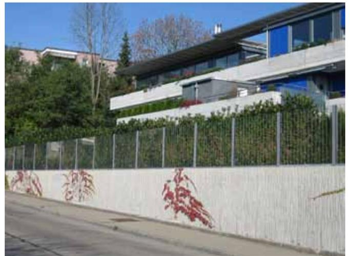
*Glaswand auf Betonmauer mit dahinterliegender Hecke.*
