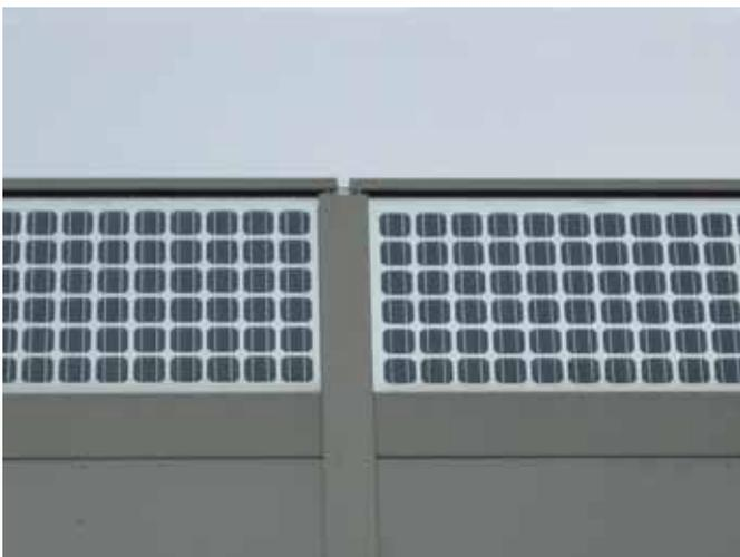
*In Lärmschutzwände integrierte Fotovoltaik Elemente.*
