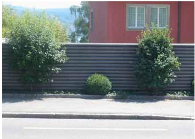
*Betonelemente mit absorbierender Wirkung und horizontalen Rippen.*
