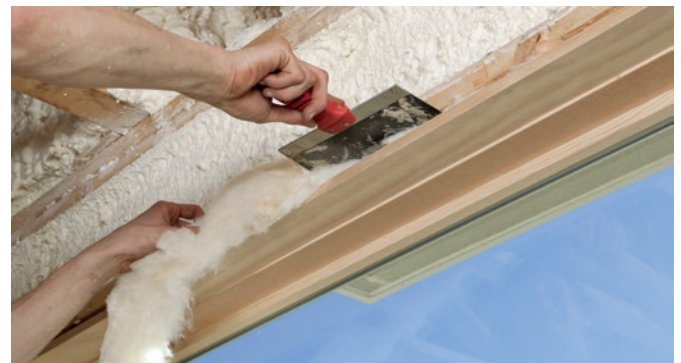
Stopfen der Fugen mit weichem Material
