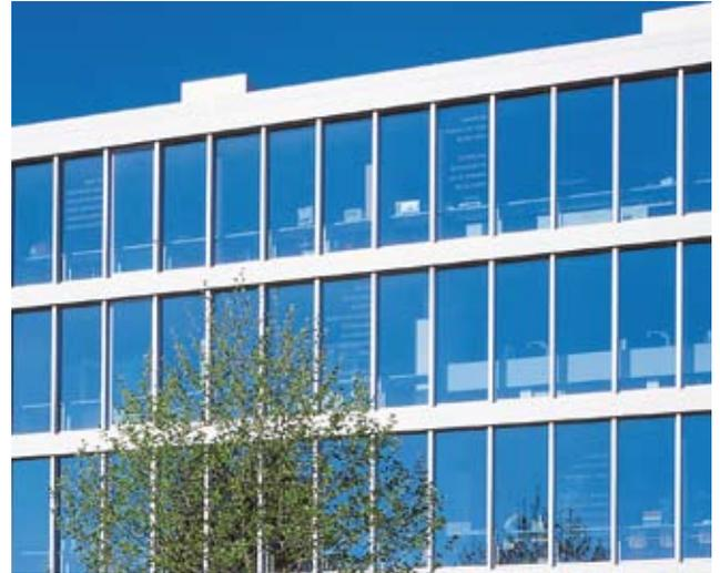
Ein transparenter Bauteil ist fix mit der Fassade verbunden, hat keinen Öffnungsmechanismus und erfüllt erhöhte Schallschutzanforderungen.
