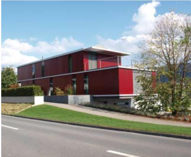
Durch den Einbau von transparenten Fassadenbauteilen auf der Strassenseite vergrössert sich der Abstand von der Lärmquelle zu den Fenstern.
