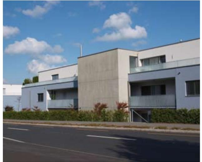
Laubgänge auf der lärmzugewandten Seite eines Mehrfamilienhauses sind ein guter Lärmpuffer. Insbesondere, wenn sie verglast sind.
