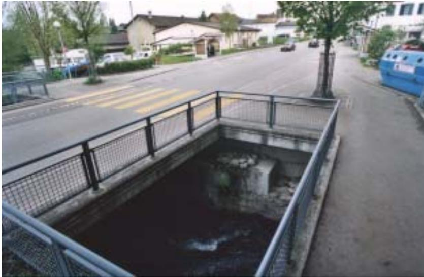
Sicht auf den Bach durch spezielle "Augen" in der Brückenkonstruktion
