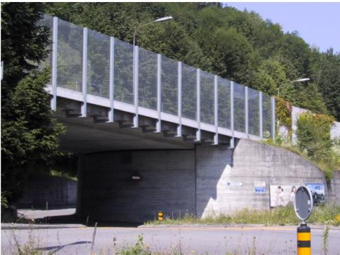
Der Massnahmentyp Wand mit Glas, der insbesondere auf Grund von Anforderungen der Wohnhygiene und/oder der Verkehrssicherheit zur Anwendung kommt. Je nach örtlichen Begebenheiten kann die Wand vollständig, teilweise oder partiell aus Glas bestehen.
