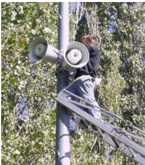
Abbildung 4: Beispielbilder von Hornlautsprechern. Links: zwei Lautsprecher montiert an einem Beleuchtungsmasten, Rechts: Modell MUH-6600 von CES Audio.
