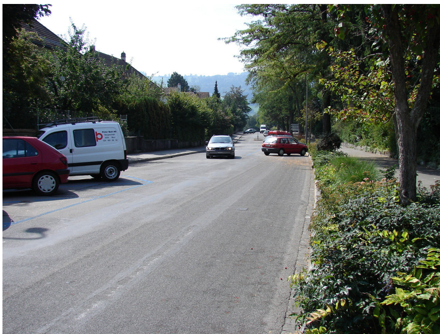
Abb. 6.3: Messung M3 – Egghölzlistrasse, Bern
