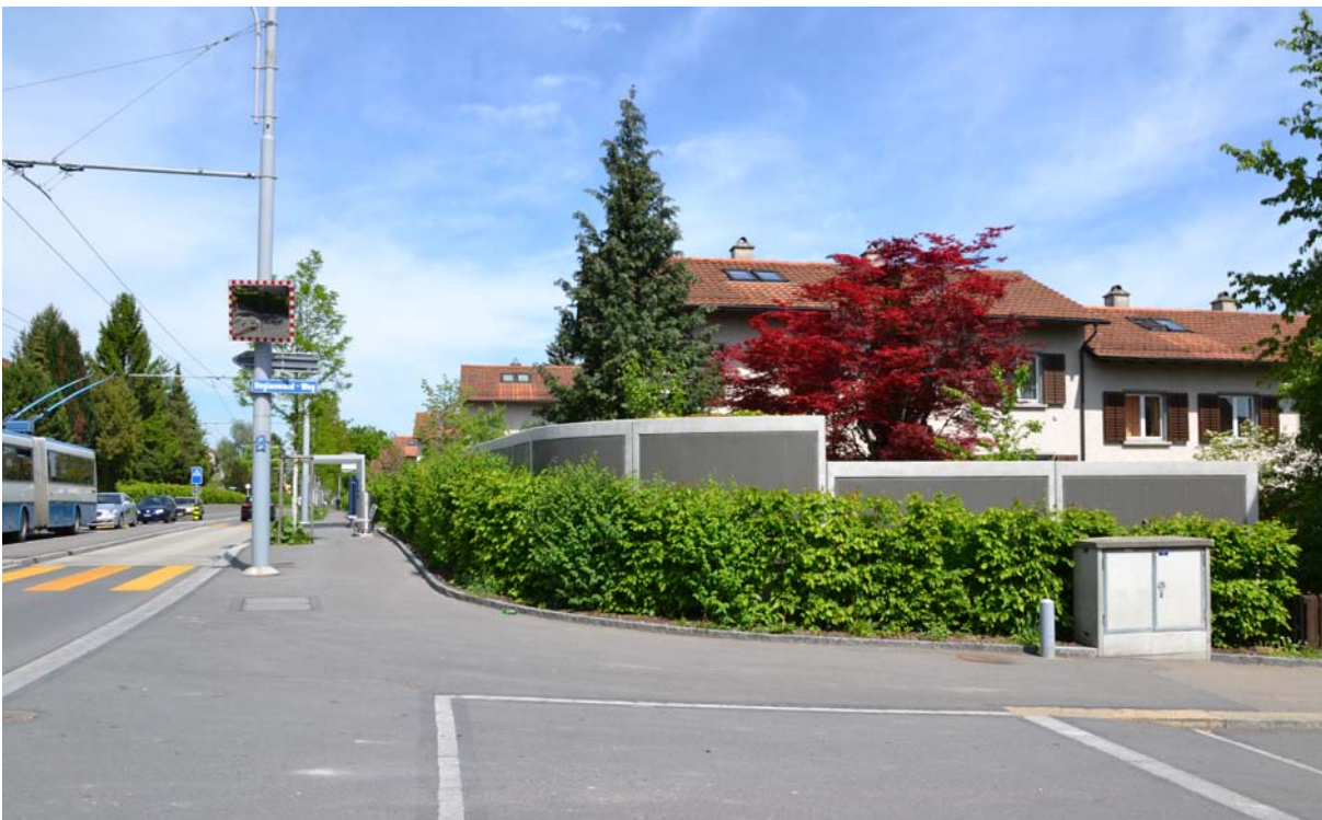
Abb. 1 Lärmschutzwand an der Schweighofstrasse
