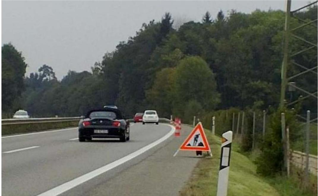
**Abb. 73** Absicherung B durch dreieckiges Warnschild 100 m vor der Messstelle und Leitkegel am äusseren Fahrbahnrand.
