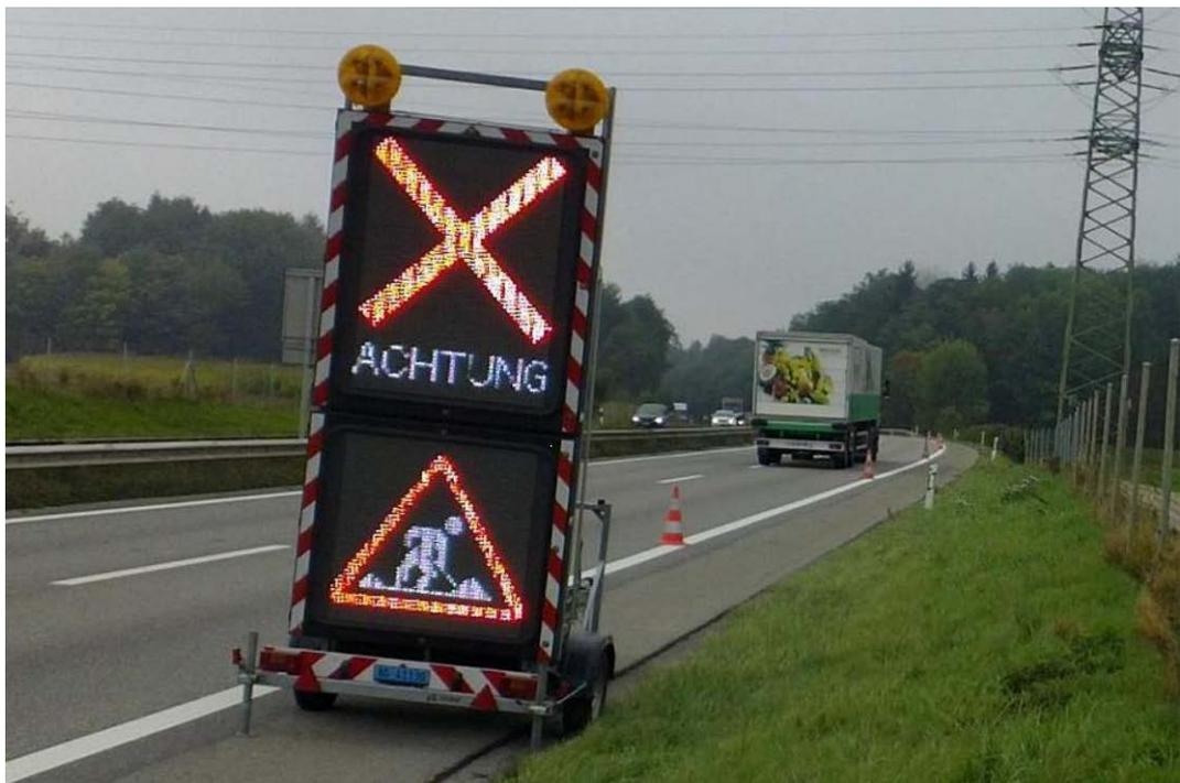
**Abb. 74** Absicherung C durch Sperrung des Pannenstreifens mit Leuchtsignalen eines Bauhoffahrzeugs 250 m vor dem Messpunkt und Leitkegel am inneren Fahrbahnrand.
