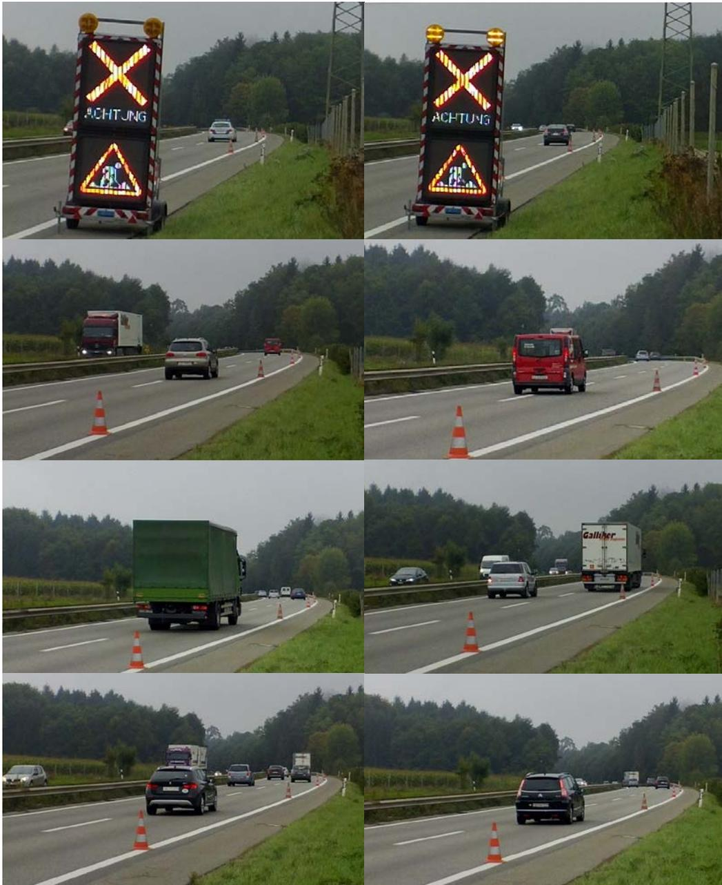
**Abb. 77** Versatz der Fahrzeuge aus der Fahrstreifenmitte bei Absicherung Typ C.
