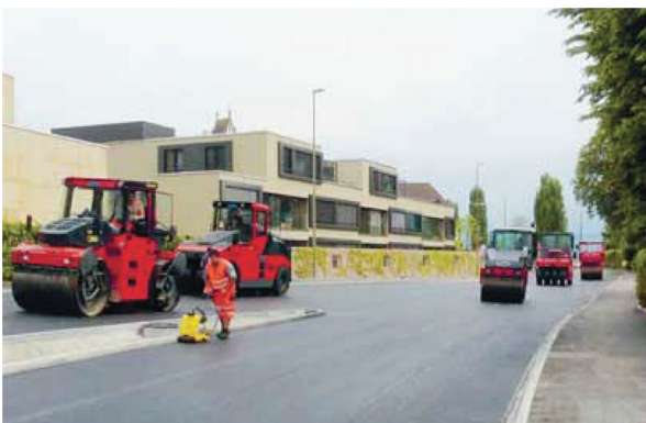
Fig. 4 : Pose d'un revêtement phono-absorbant (source : TBA ZH)
