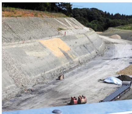
10 | Einschnittböschung in verschiedenen Boden- und Gesteinsschichten.
